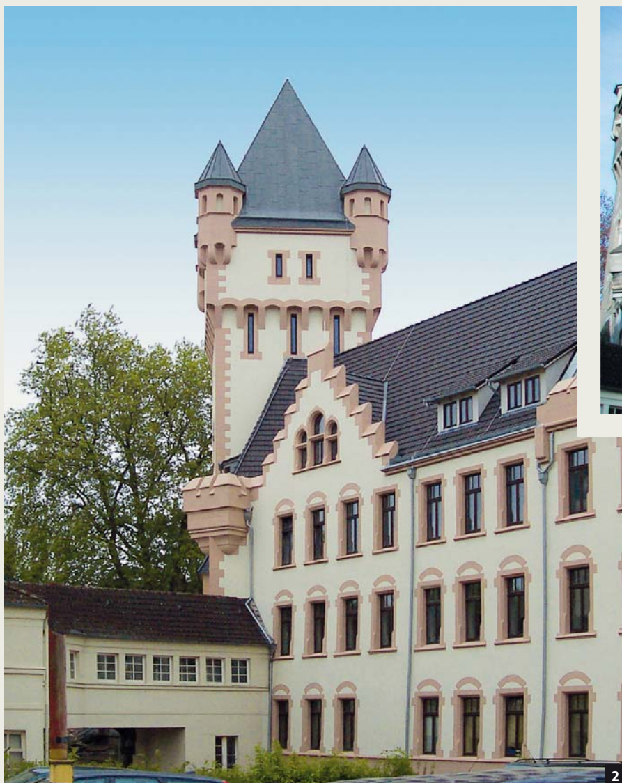
Abb. 2/3: Nach der nach historischem Vorbild durchgeführten Sanierung zeigt sich das Gebäude wieder als prächtiger Blickfang, auch der Turm der Hördter Burg, der als historisch bedeutsam gilt.
